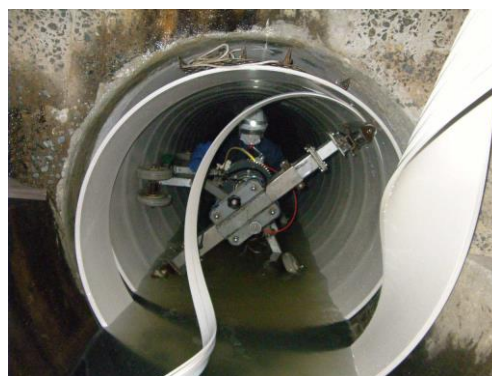
管更正*の工事現場写真
