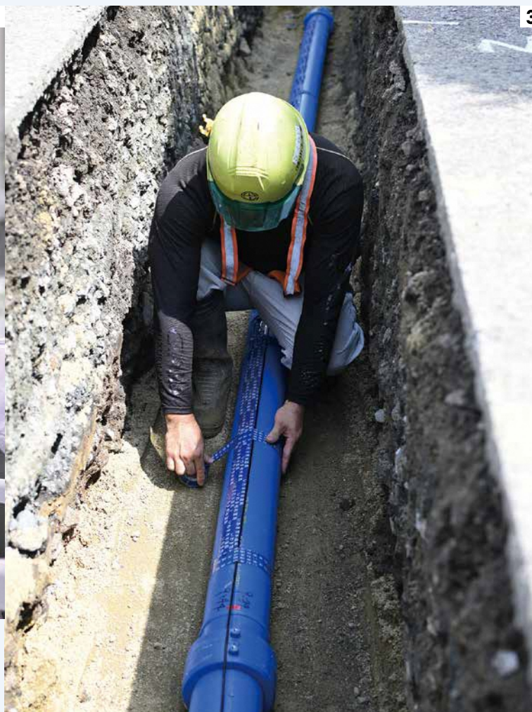
①②整備が進む中部配水池 ③水道管の布設替え
