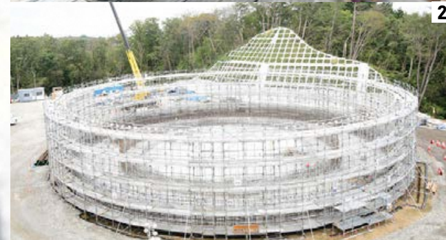
①②整備が進む中部配水池 ③水道管の布設替え
