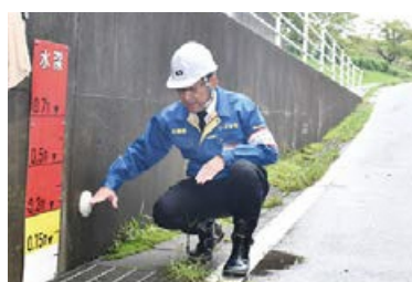
▲浸水箇所の現地調査
