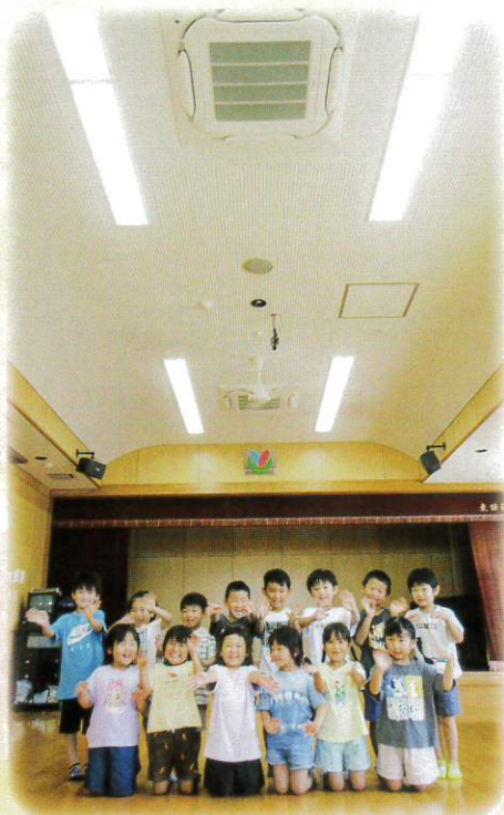
空調設備機器入替事業：東田保育園
