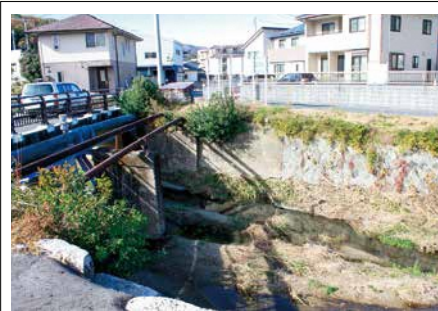
■写真2 撤去された専用鉄道内郷線の橋脚跡 〔令和7（2025）年11月 小宅幸一撮影〕
