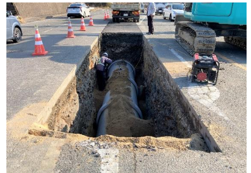
写真 6-1 雨水管渠施工状況
