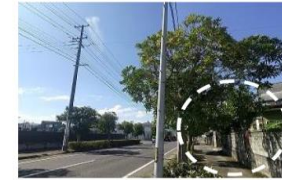
(枝葉により歩行空間を狭めている事例)
