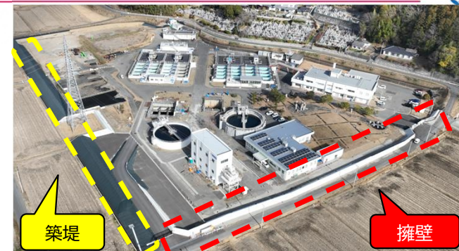
平浄水場 浸水対策(R5~R7)
