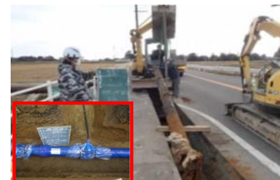
老朽管更新工事 市内各所にて
