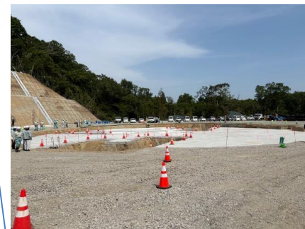
中部配水池の建設様子(R10竣工予定)
