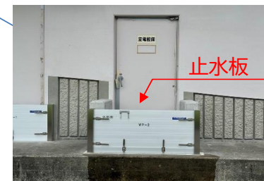
好間ポンプ場 浸水対策(R6)
