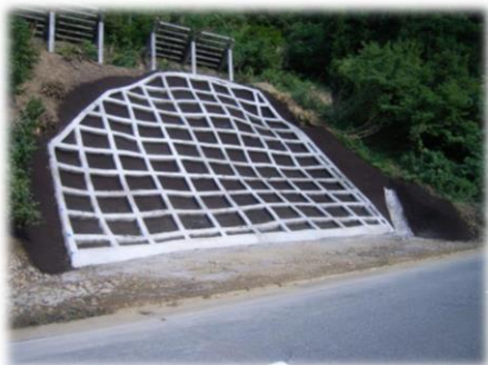
対策事例：法枠工
