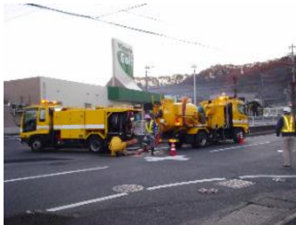
下水道管の維持管理の光景（専用車両による洗浄）
