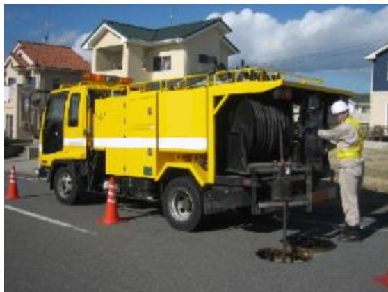
下水道管の維持管理の光景（専用車両による洗浄）
