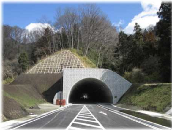
市道 内郷・湯本線（堀坂トンネル）
