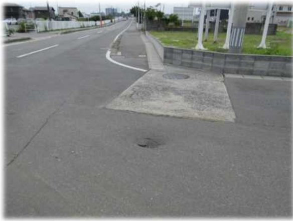
市道 搔槌小路・上柳生線（整備前）
