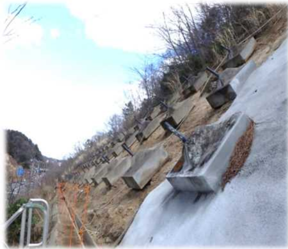
対策事例：モルタル吹付（整備前）
