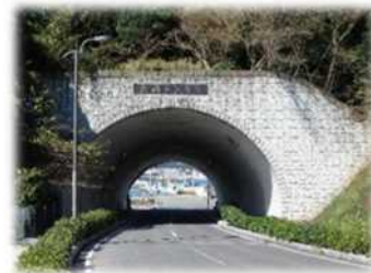
トンネル（小名浜地区）
