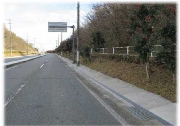
市道 荒神作・勝負作線（整備後）
