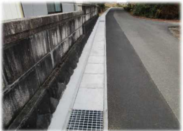
市道 平久田1号線（整備後）
