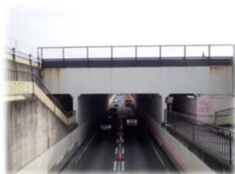
大型カルバート（泉地区）
