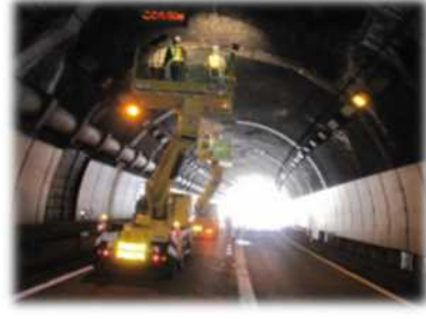
トンネルの点検
