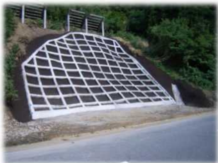
対策事例：法枠工
