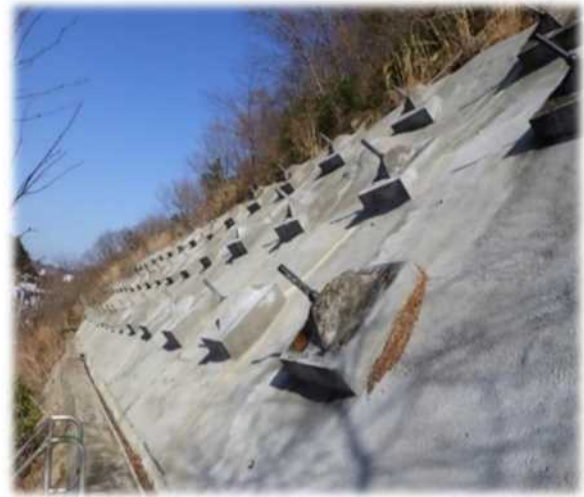
対策事例：モルタル吹付（整備後）
