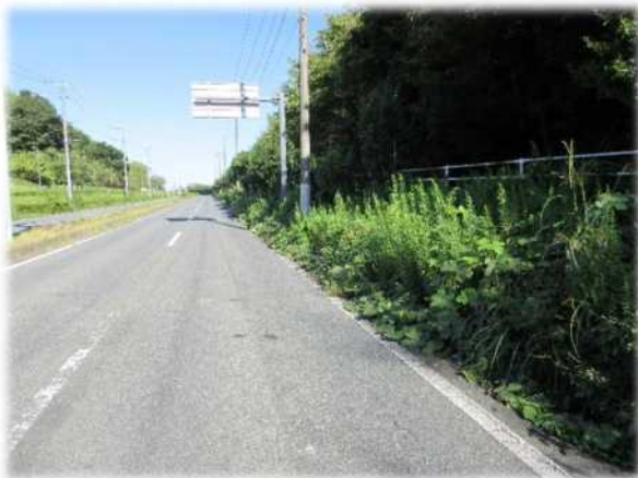
市道 荒神作・勝負作線（整備前）
