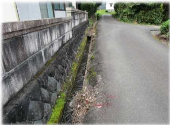
市道 平久田1号線（整備前）
