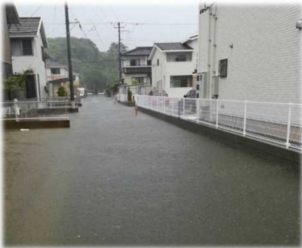
市道 後原2号線（整備前）
