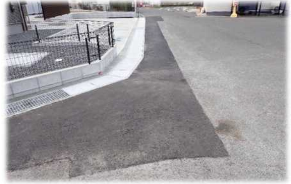
市道 上代・家ノ前線（整備後）
