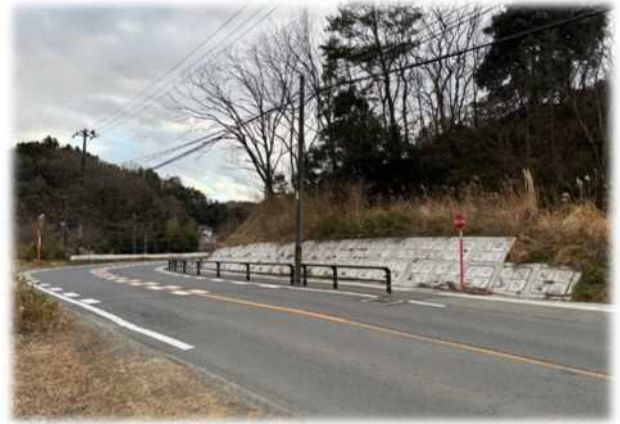
市道 下浅貝・亀ノ尾線（整備後）
