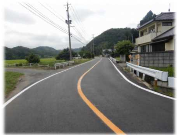
市道 北白土・菅波線（整備後）
