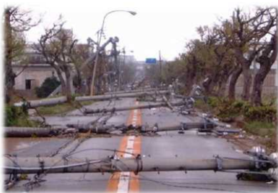
災害時の救急活動を妨げる電柱
