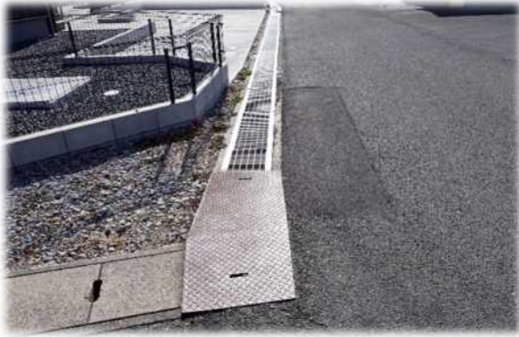
市道 上代・家ノ前線（整備前）
