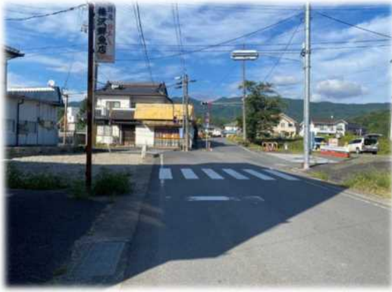
市道 清水・空木線（整備中）
