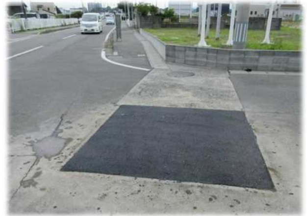
市道 搔槌小路・上柳生線（整備後）
