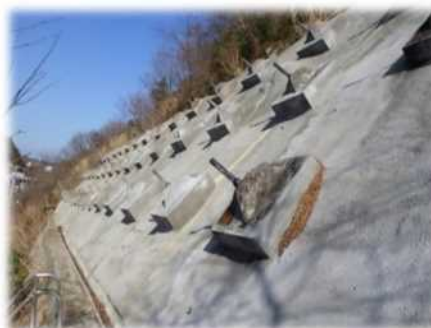
対策事例：モルタル吹付工
