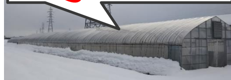
農業用ハウスの補強対策済み
