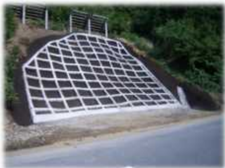
対策事例：法枠工
