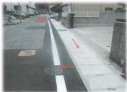
対策事例：側溝改修（断面拡大）
