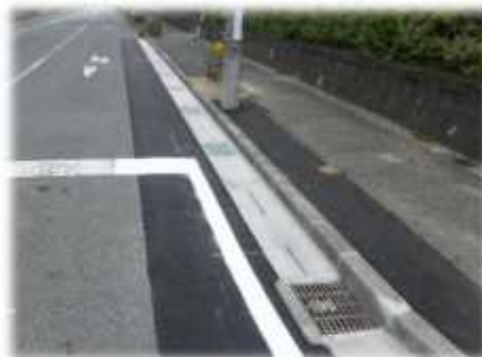
対策事例：側溝改修（構造改善）
