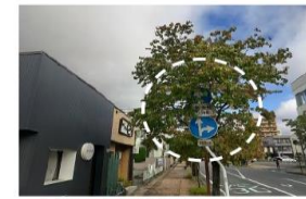
(枝葉により標識が見えにくい事例)
