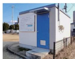
耐震性貯水槽は、平常時に配水管の一部として使用していますが、災害時には飲料水を貯留し給水所として使うことができます。市内26か所に設置してあります。水道局ホームページで場所を確認しましょう。
