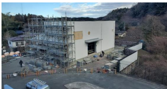
(自家発電棟/建築工事中 令和7年12月末)
