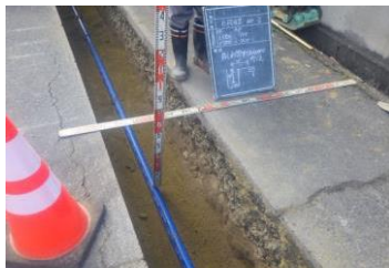
老朽管を撤去し新たな管を布設している様子
