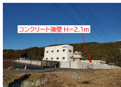
(擁壁工施工状況)
