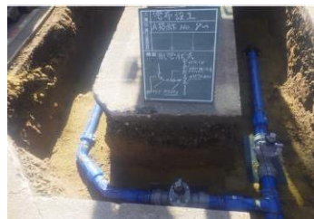
老朽管を撤去し新たな管を布設している様子
