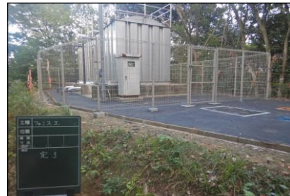
堤ノ上調整池更新工事 SUS調整池
