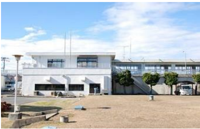
泉浄水場(昭和39年建設)
