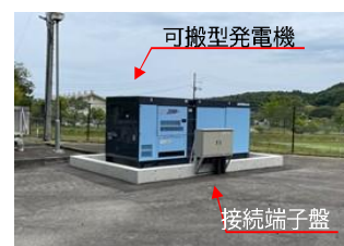
田部ポンプ場の可搬型発電機(令和4年度)
