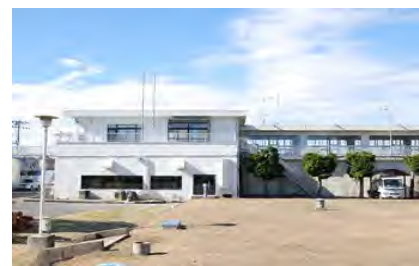
泉浄水場(昭和39年建設)
