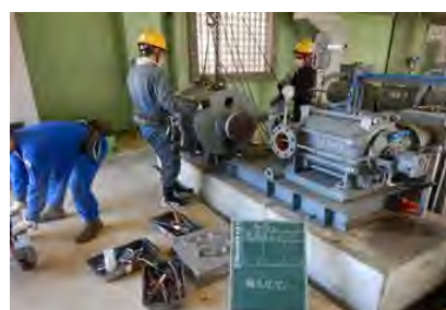
中央台ポンプ場 ポンプ設備の更新工事
