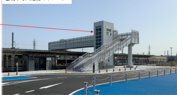
写真 四ツ倉駅跨線人道橋
