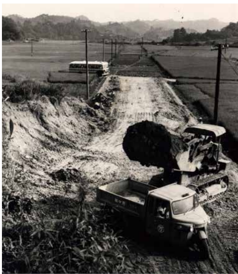
■写真 鹿島街道新設工事、横切る旧道バス、小名浜方面を見る〔昭38(1963)年3月、比佐不二夫氏撮影〕
