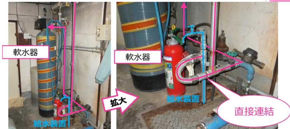
給水装置と未承認機器（軟水器）が直接連結されている
