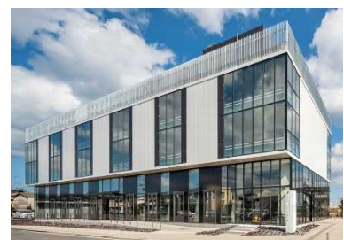
久之浜・大久支所 (地域防災交流センター 久之浜・大久ふれあい館)
