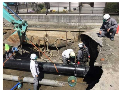
地震に強い水道管への 取替え工事
