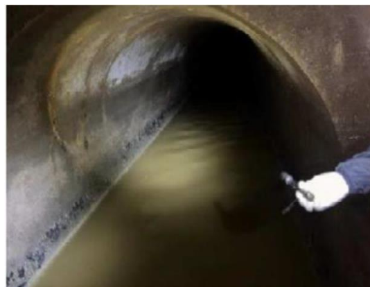
下水道管路の緊急点検の様子（目視点検）
