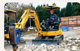
▲瓦礫の撤去作業
