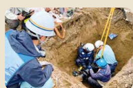
▲漏水修理作業
