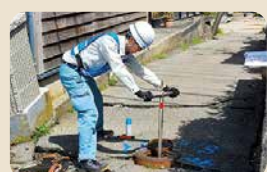
▲水道管復旧作業
