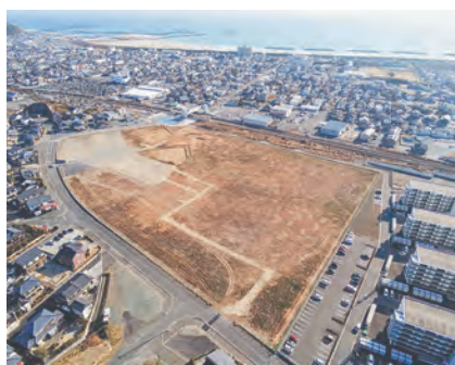
▲四倉地区交流・防災拠点施設の整備予定地
