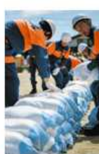
【土のうによる消防団水防工法訓練】
