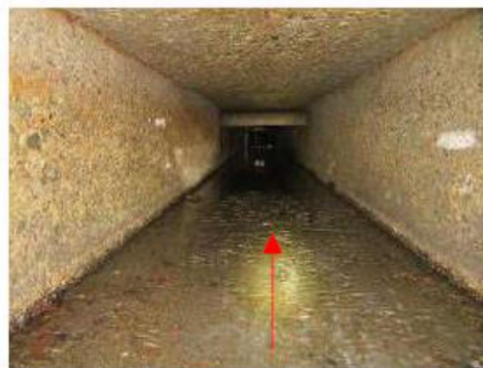
②暗渠雨水管の内部状況 (堆砂高 H=45cm)
