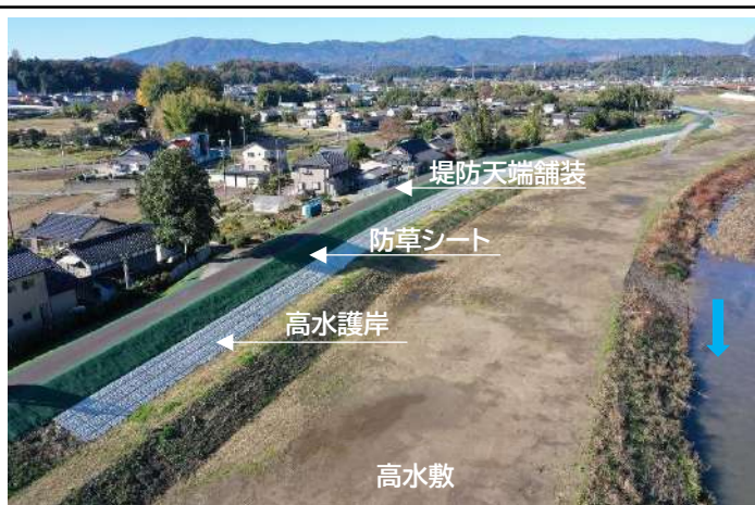
堤防天端舗装の施工状況
