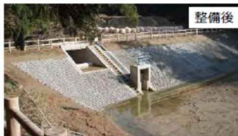
堤体の補強及び法面保護による浸食防止
