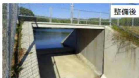
ため池の洪水吐きの改修（洪水流下能力の増加）
