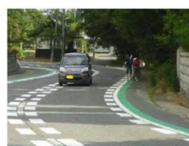
交通安全対策（カラー舗装）
