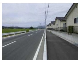
道路の拡幅整備（片側歩道）
