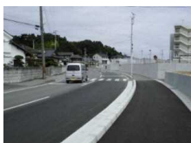
道路の拡幅整備（両側歩道）
