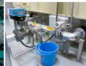
(蓄電システム装置・受水槽に取り付けた蛇口)
