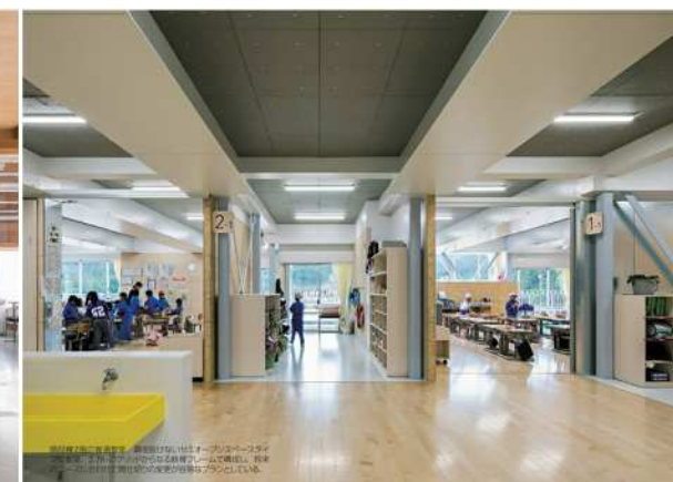
グリッド上の鉄骨フレームにより、将来ニーズ合わせて間仕切りの変更が可能なつくり
