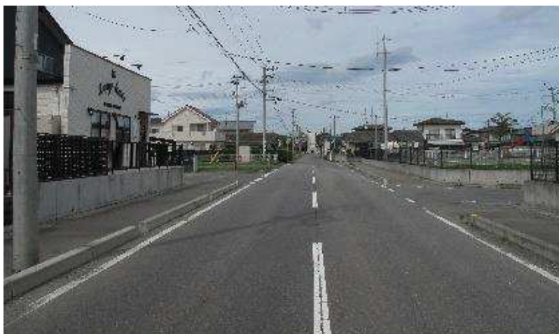
写真 歩道が整備された区間（市道梅ヶ丘1号線）
