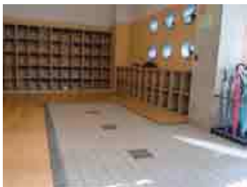
写真 段差を無くした入口部
