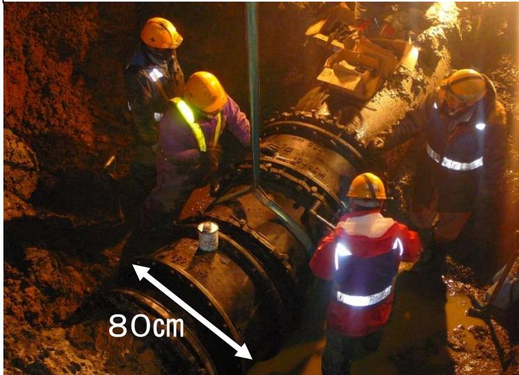
東日本大震災時の山玉浄水場口径800mm送水管修理の様子
