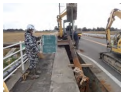
老朽管を撤去し新たな管を布設している様子
