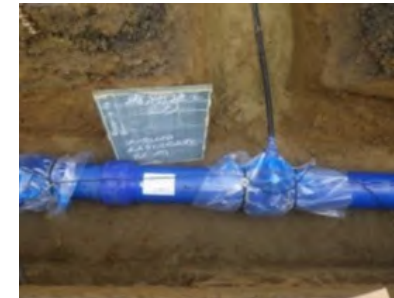
老朽管を撤去し新たな管を布設している様子
