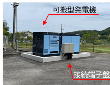
田部ポンプ場の可搬型発電機(令和4年度)
