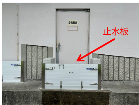
好間ポンプ場 止水板対策後(令和6年度)
