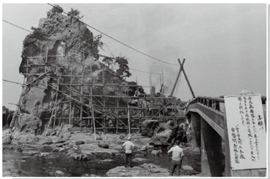
■写真 弁天島の補強工事 (昭和52(1977)年7月、いわき市撮影)
