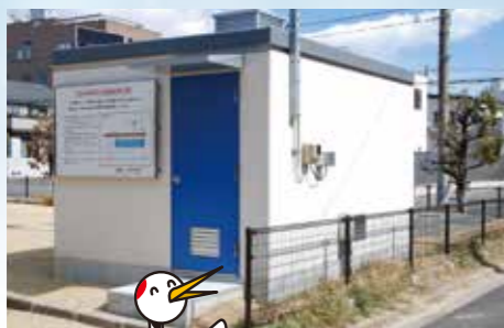
水道局本庁舎前にある、耐震性貯水槽のモデルです。容量は実際の10分の1で、4㎡(4,000ℓ)が蓄えられています。
