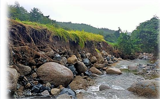
【河川】普通河川 相川(河岸崩落)
