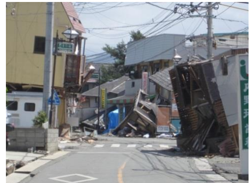
地震で損壊した建物
