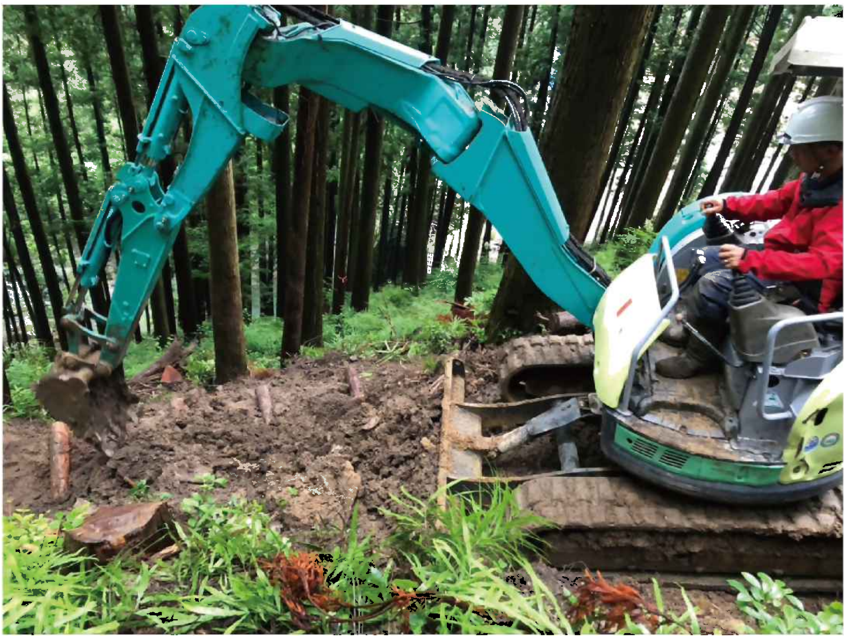
※見えづらいですが、間伐材を使って木組みする事で、作業道を支える箇所を作っています。数年をかけて雑草が生える事で、崩れない道が完成するそうです。
