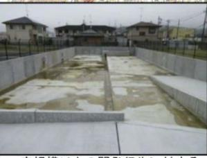
一定規模以上の開発行為に対する雨水貯留施設等の設置(いわき市)
