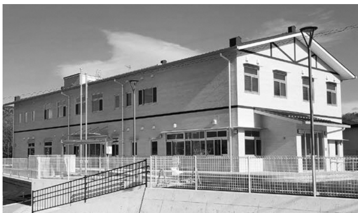
今月30日より供用開始する「小川支所新庁舎」
