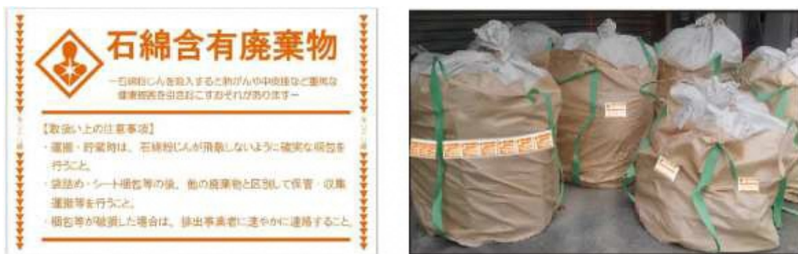
図3-7 石綿含有廃棄物の表示テープ
