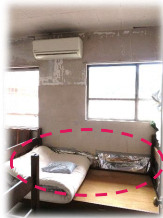
旧耐震基準の施設の例 内郷消防署(築60年)
