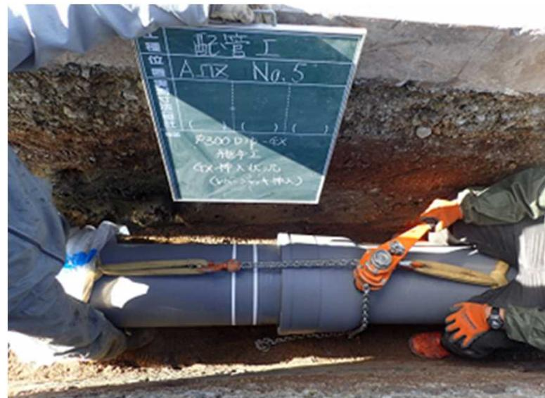
＜老朽管更新の様子(左:老朽化の状況 右:耐震管の布設の様子)＞
