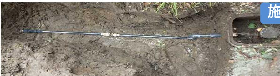
〈鉛製給水管の布設替えの状況〉
