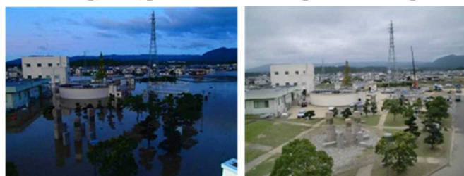
濃縮槽、脱水機棟、排水池（浸水深 地盤から約125cm）
