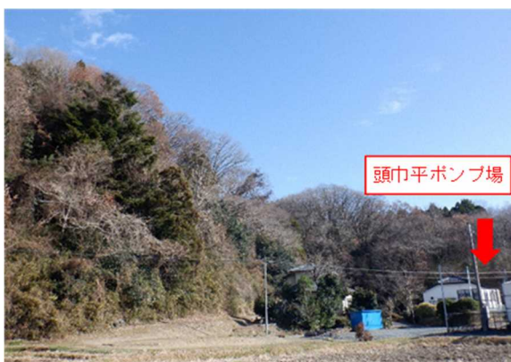
図 頭巾平ポンプ場 現地調査写真
