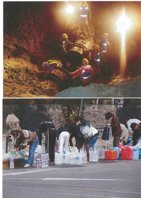
図 東日本大震災における被害状況
