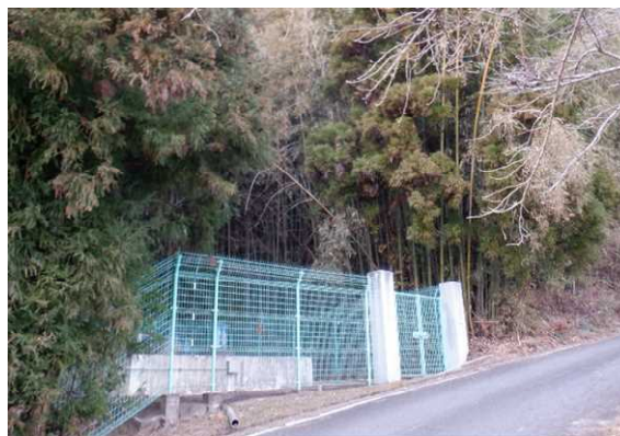
図 下ヶ屋敷調整池 現地調査写真
