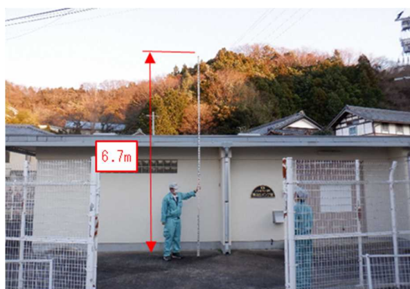
図 4-12 南白土ポンプ場
