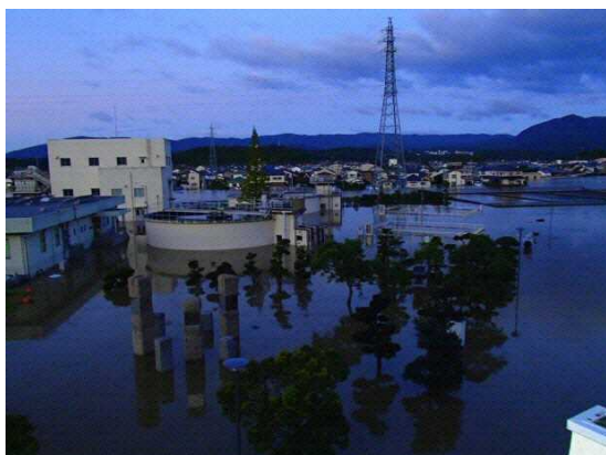
濃縮槽、脱水機棟、排水池(浸水深 地盤から約 125cm)
