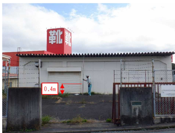
図 4-13 諏訪下ポンプ場
