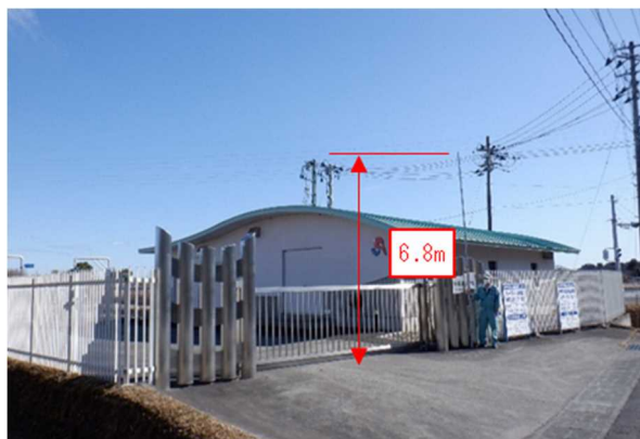
図 4-16 好間ポンプ場
