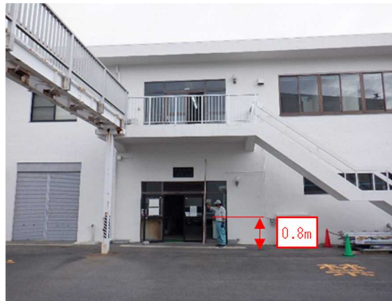
図 4-11 泉浄水場(管理棟)
