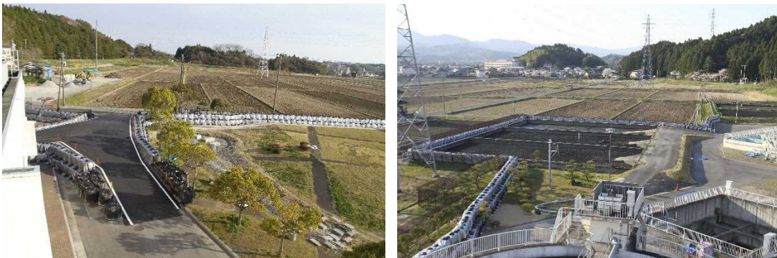
図 4-4 大型土のう積(平浄水場)
