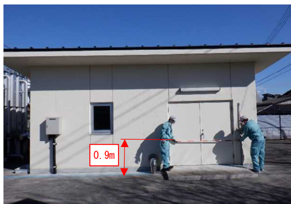
図 4-17 薬王寺ポンプ場
