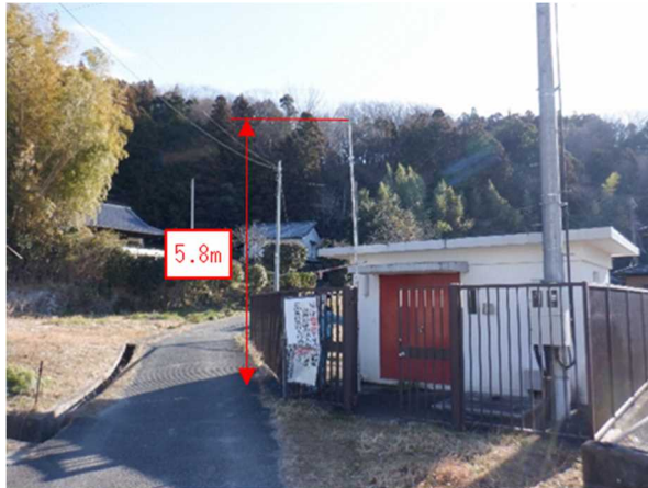
図 4-15 独古内ポンプ場
