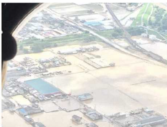
大雨により冠水した倉敷市内
