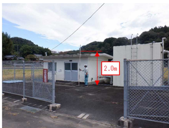
図 4-18 釜戸第1ポンプ場
