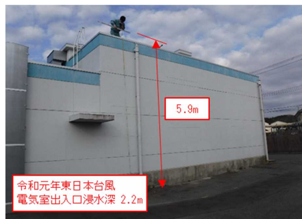
図 4-8 下平窪取水場(電気室)
