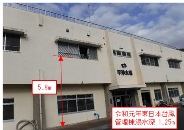
図 4-9 平浄水場(管理棟)
