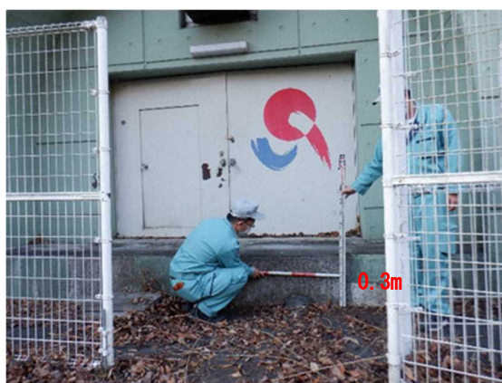
図 4-7 神白ポンプ場
