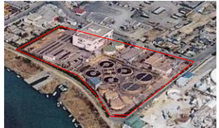
【東部浄化センター全景(上)・老朽化状況写真(下)】
