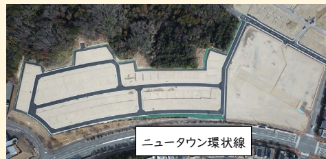
▲造成が完了した第1工区
