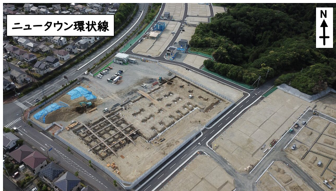
▲商業施設（マート）の工事の様子
