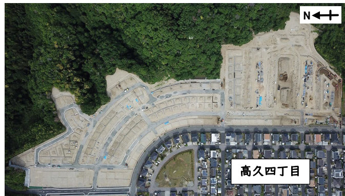
▲2～4工区の宅地造成工事の様子
