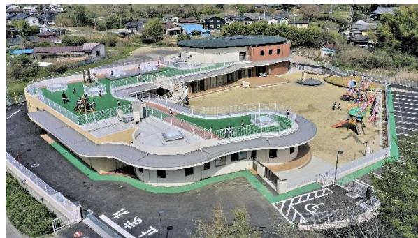
〈令和 5 年 1 月完成〉
